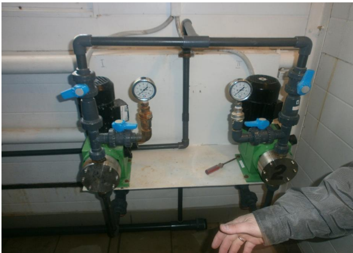
Рисунок 33. Насосы дозаторы.
