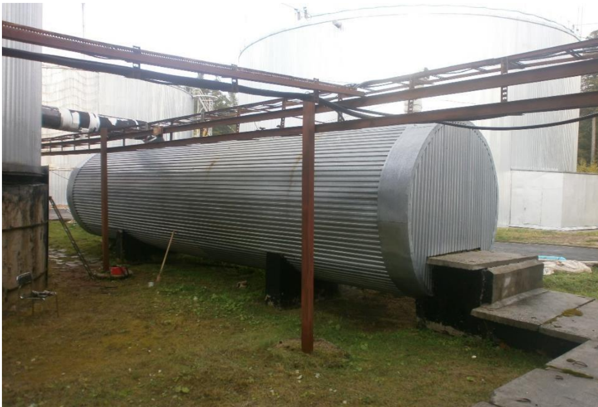
Рисунок 26. Промежуточная емкость объемом 100 м 3 .
