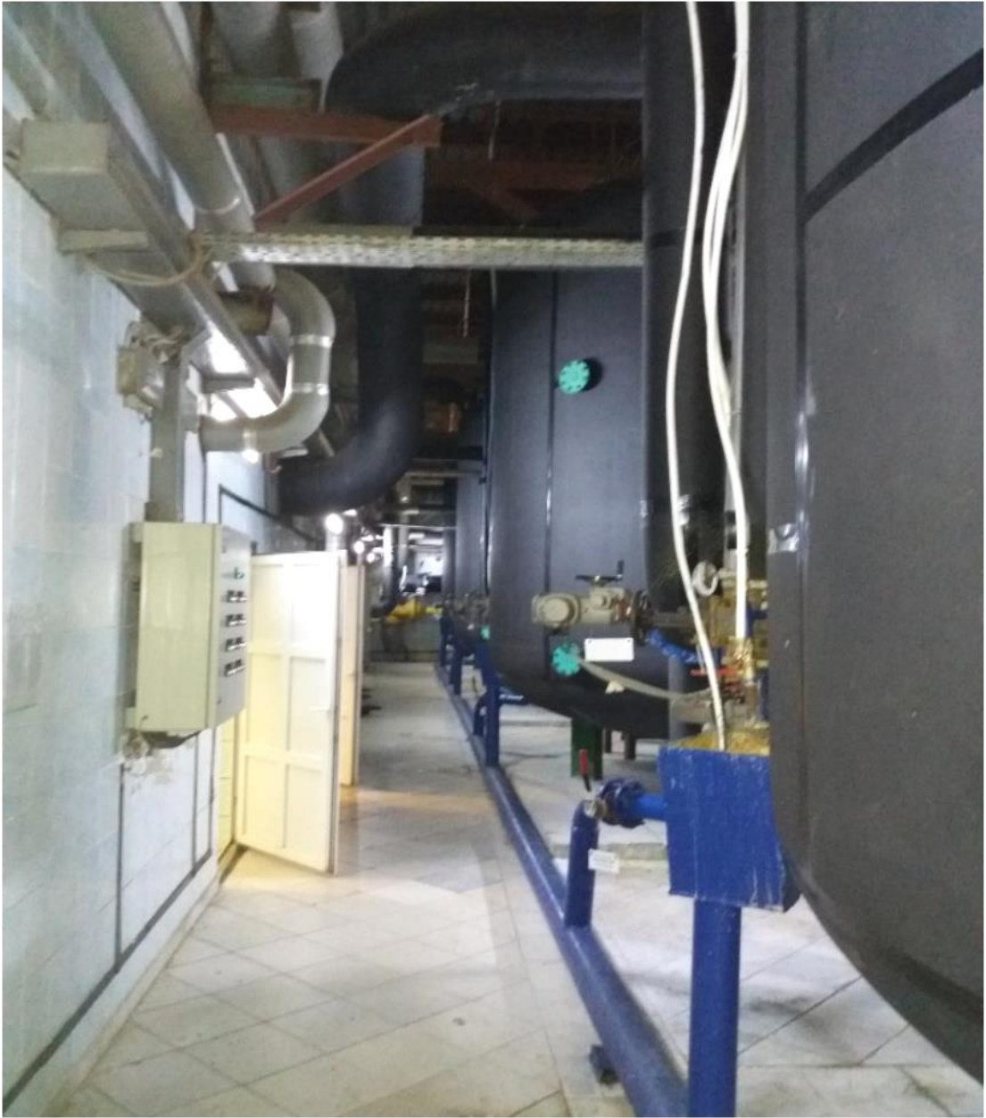
Рисунок 19. Помещение фильтров 1-й ступени.
