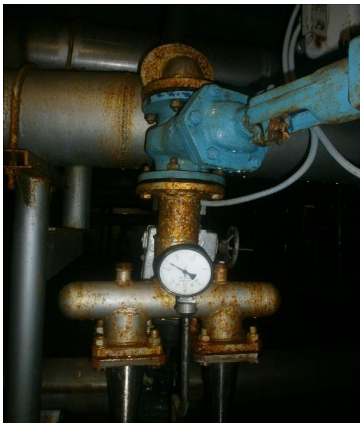
Рисунок 25. Вакуумно-эжекционный аппарат.
