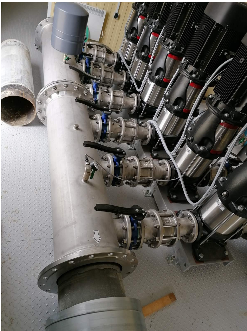
Рисунок 44. УПД в районе ул. Ледовая, 1.
