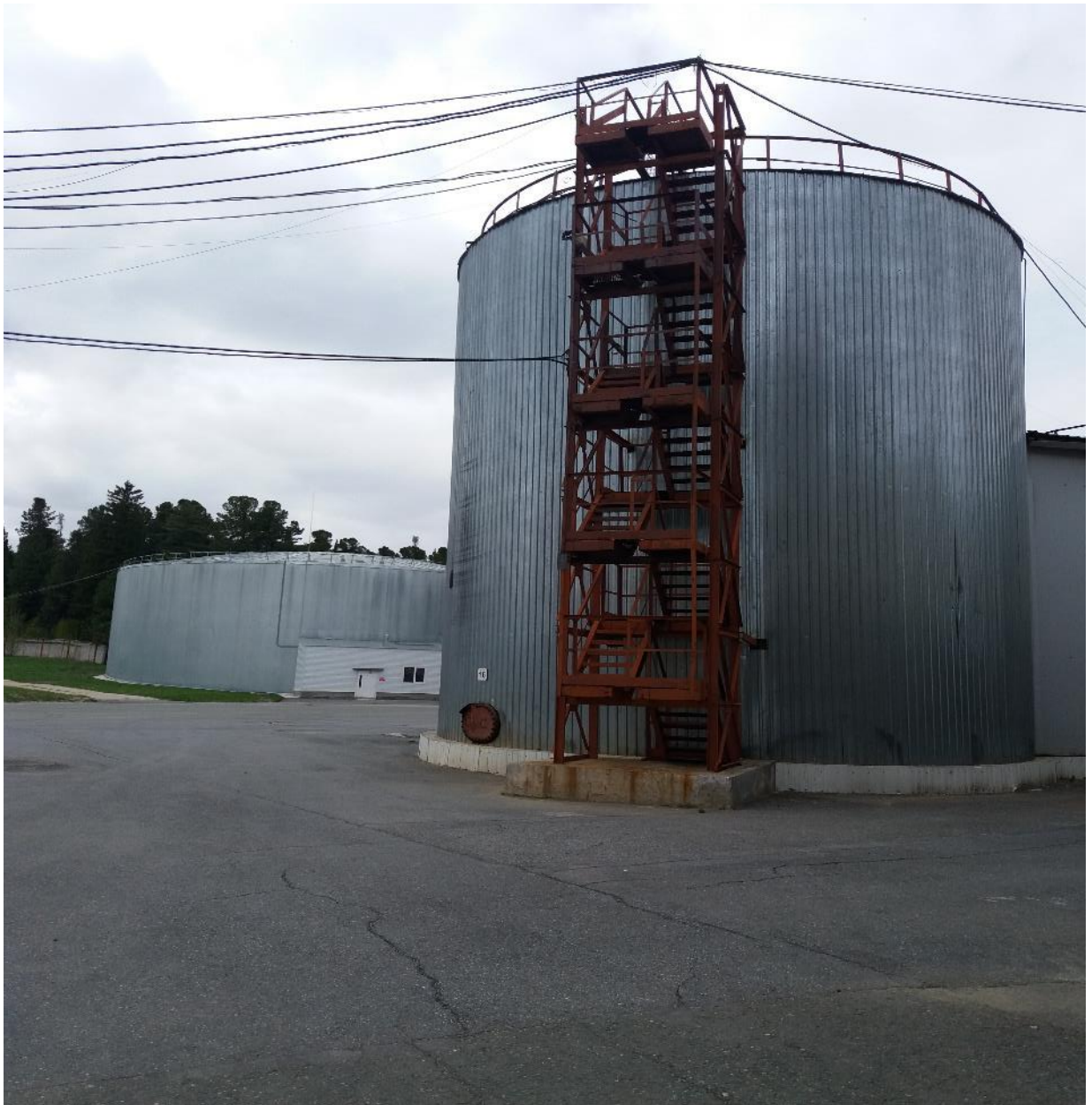
Рисунок 21. Резервуар-усреднитель объемом 1000 м 3 .
