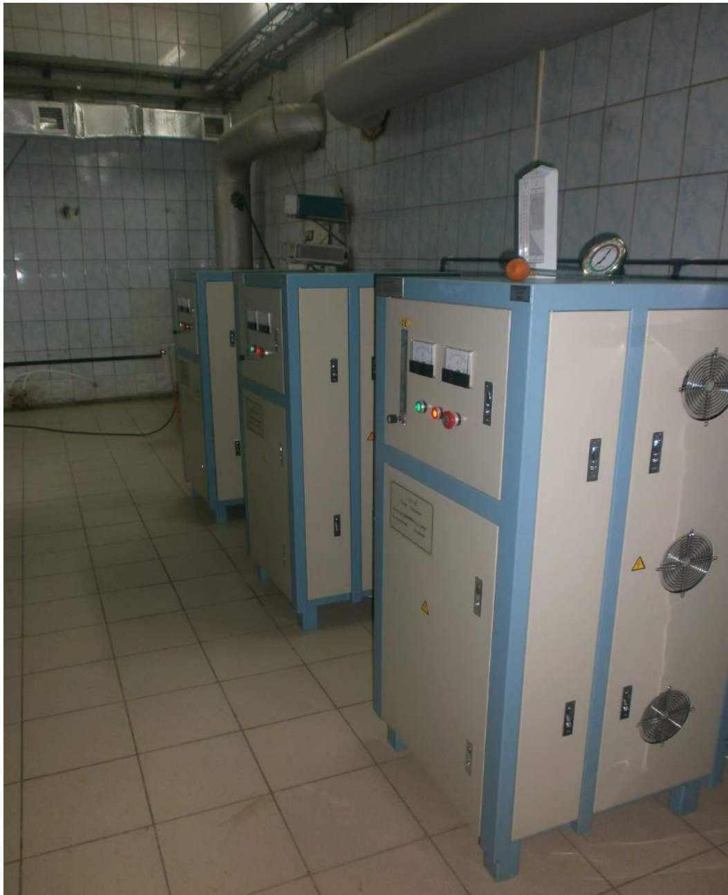
Рисунок 30. Генераторы озона.
