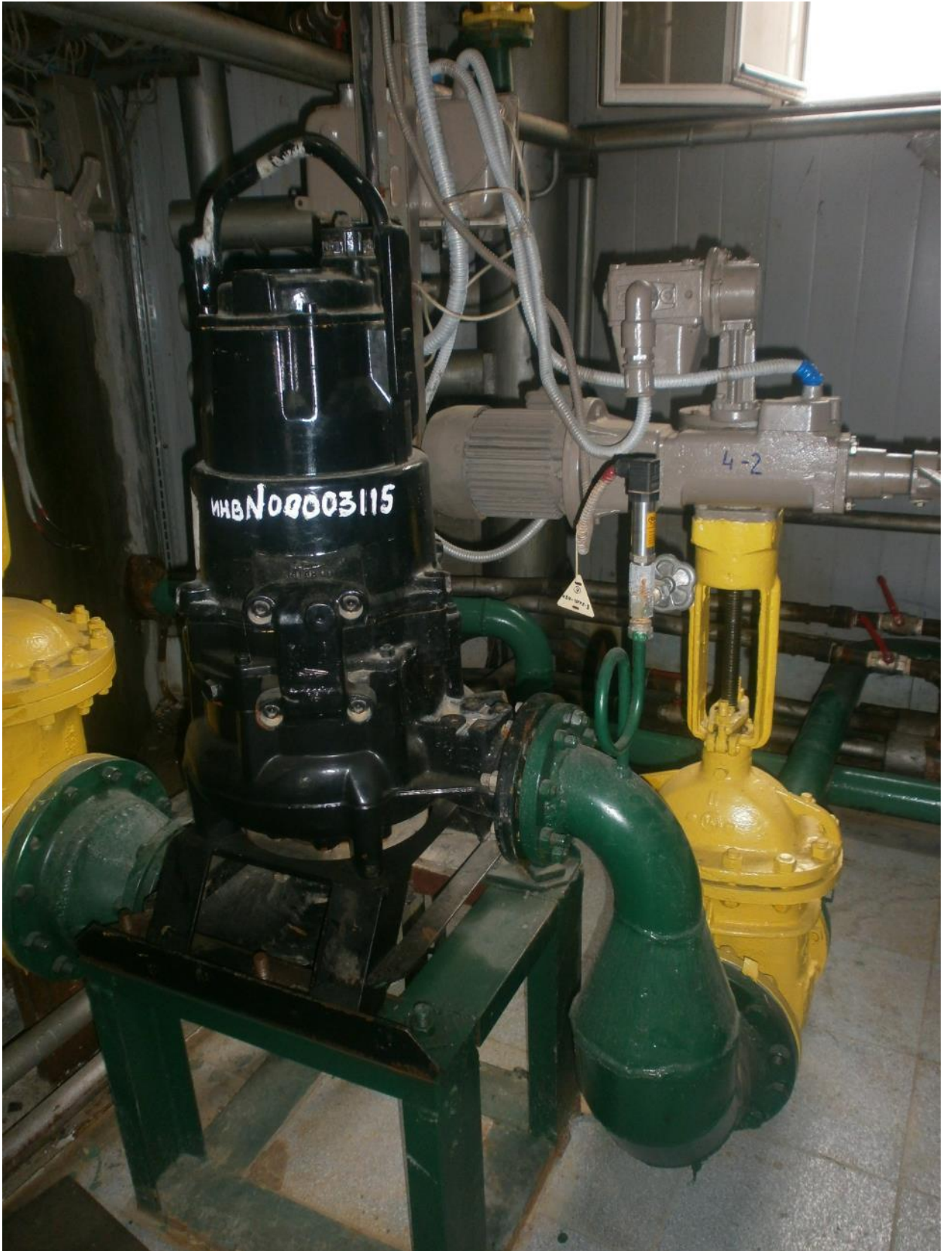
Рисунок 23. Насос для перекачки осадка.
