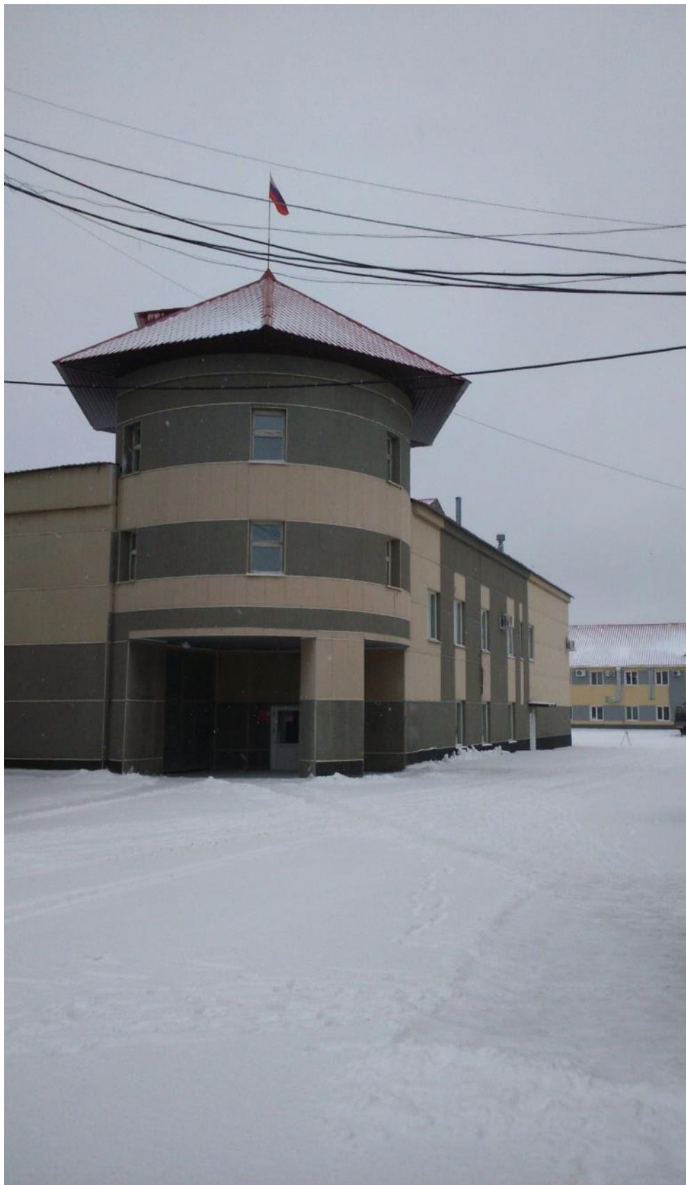
Рисунок 16. Здание насосно-фильтровальной станции ВОС.
