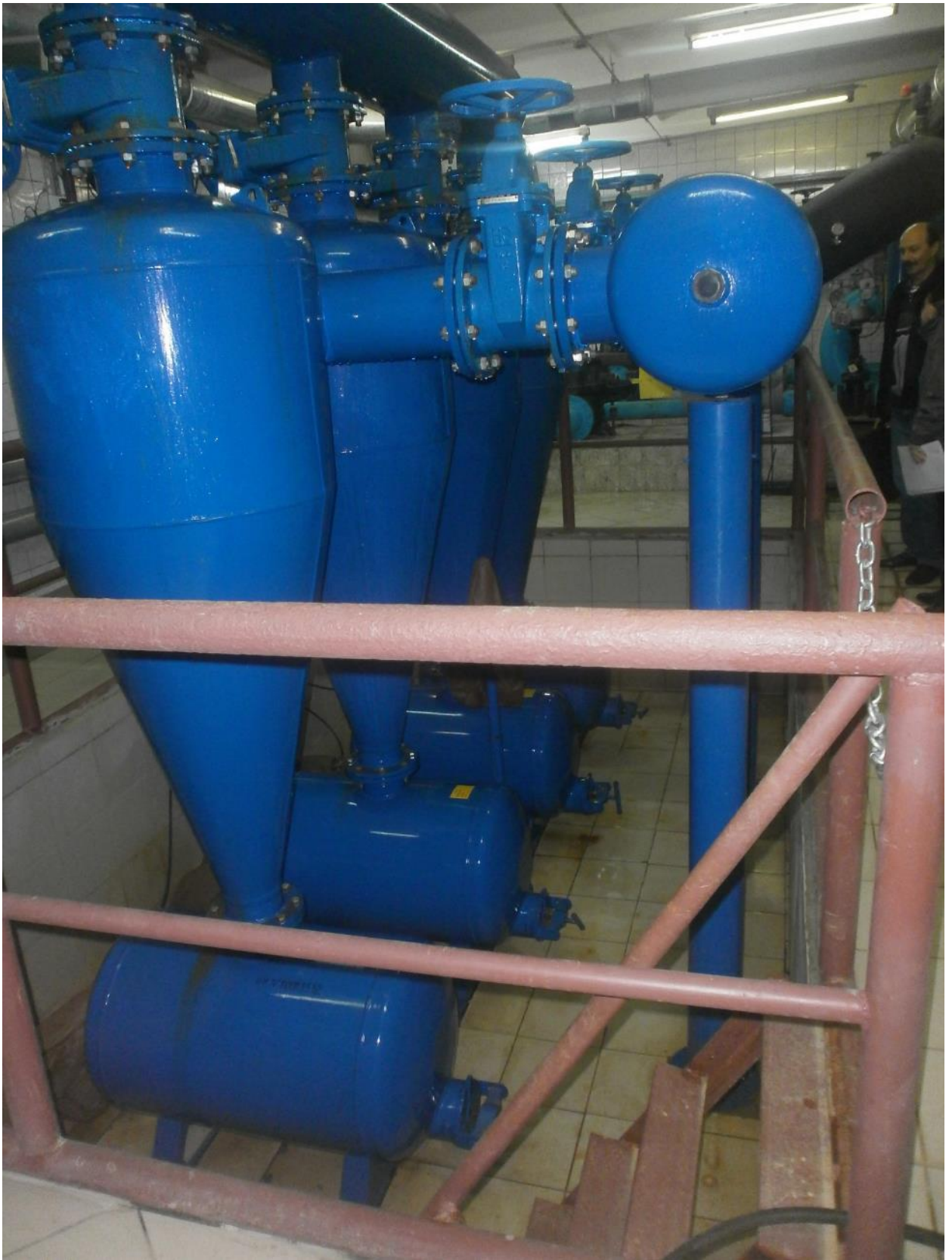
Рисунок 18. Гидроциклонная установка.
