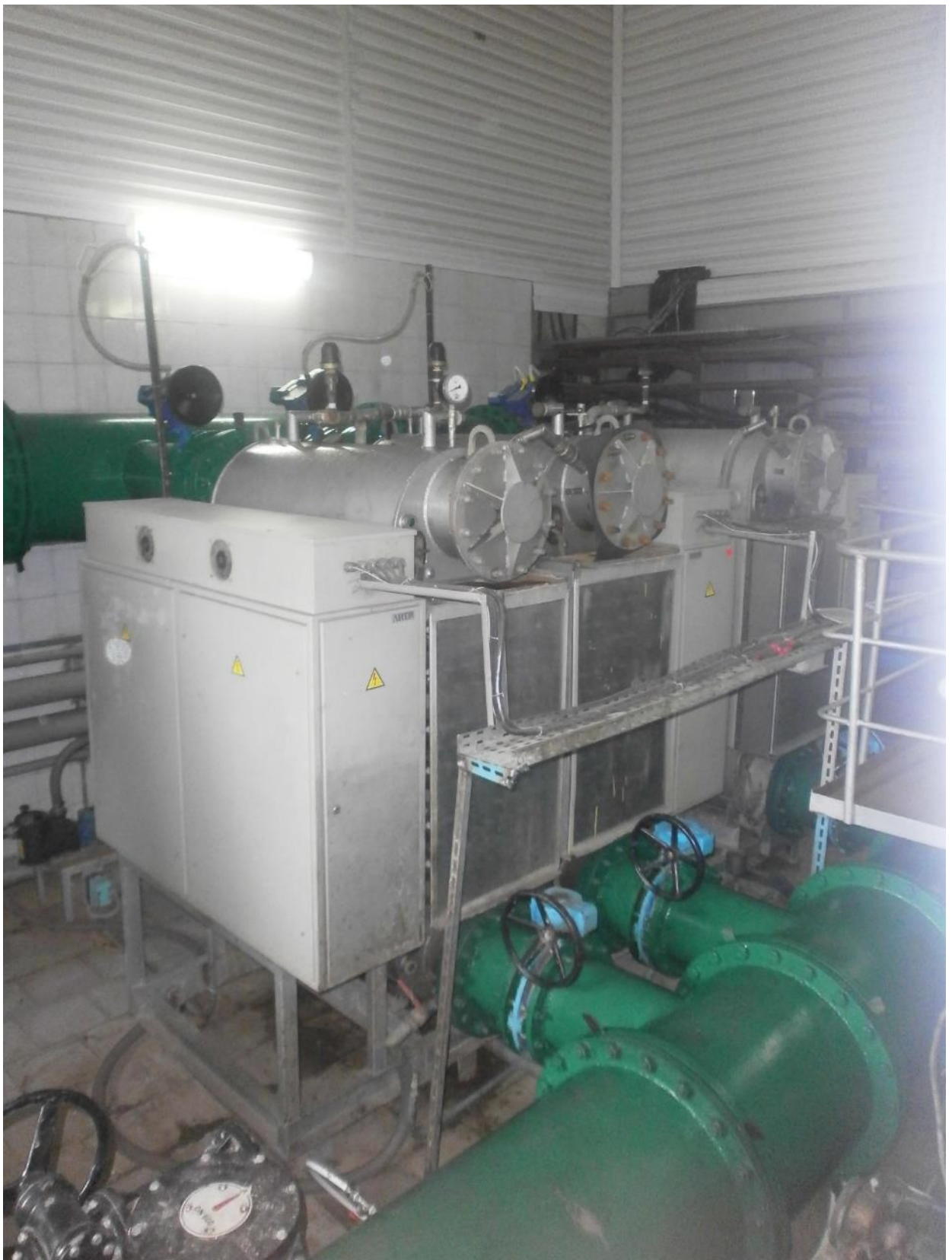
Рисунок 31. Бактерицидные установки УДВ-500-72.
